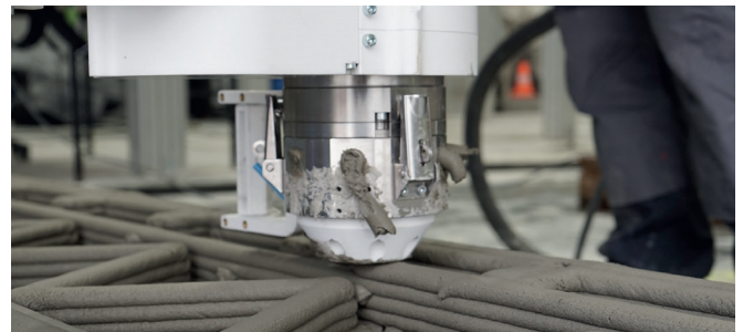
② AG106-Processo de Extrusão Extrusor em operação com adição de reforço em fibra de vidro
